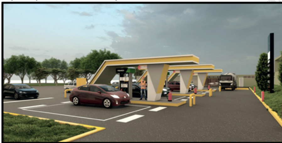
Figura N° 3 Proyecto Grifo Cuartel General – San Borja
